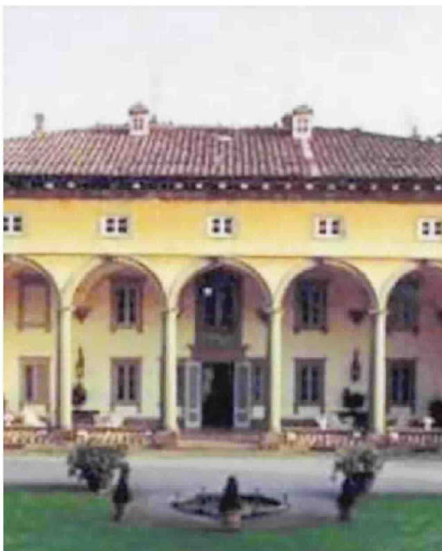
Il corpo centrale di Villa Oliva a San Pancrazio
